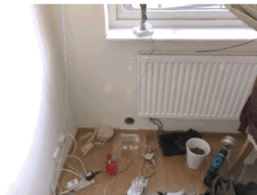
Foto 25- Inspektionshål i yttervägg mot nordost
